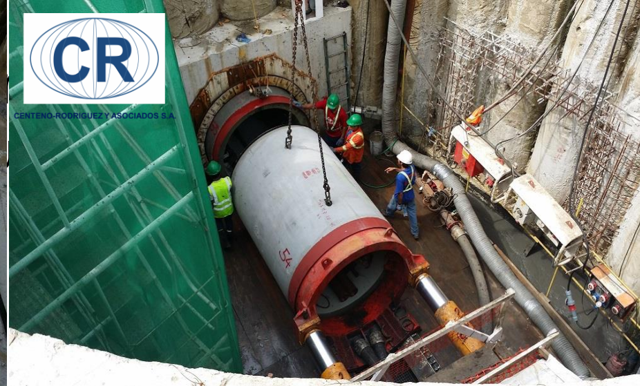
Bajando el Tubo y posicionando
