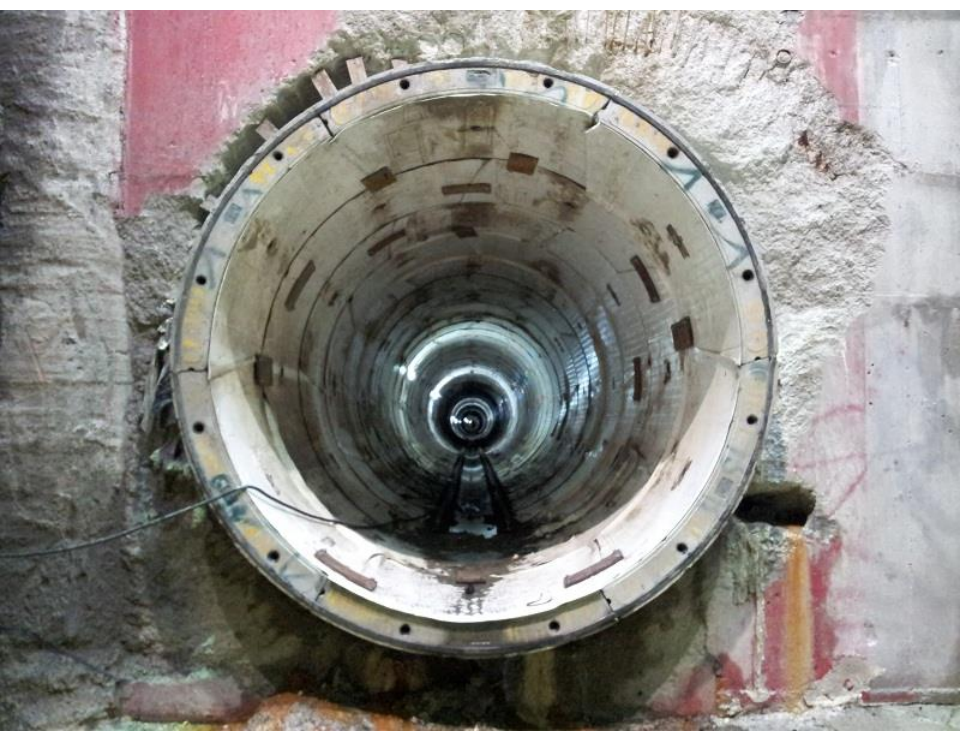
Foso de salida (Av. Balboa) Cinta Costera Ciudad Panamá Túnel interceptor: 8 Km con Ø3.4m
