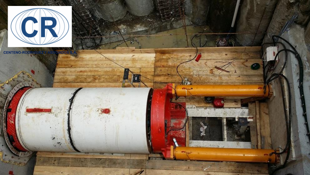
MTBM Pipe Jacking System (Cabeza de corte)
