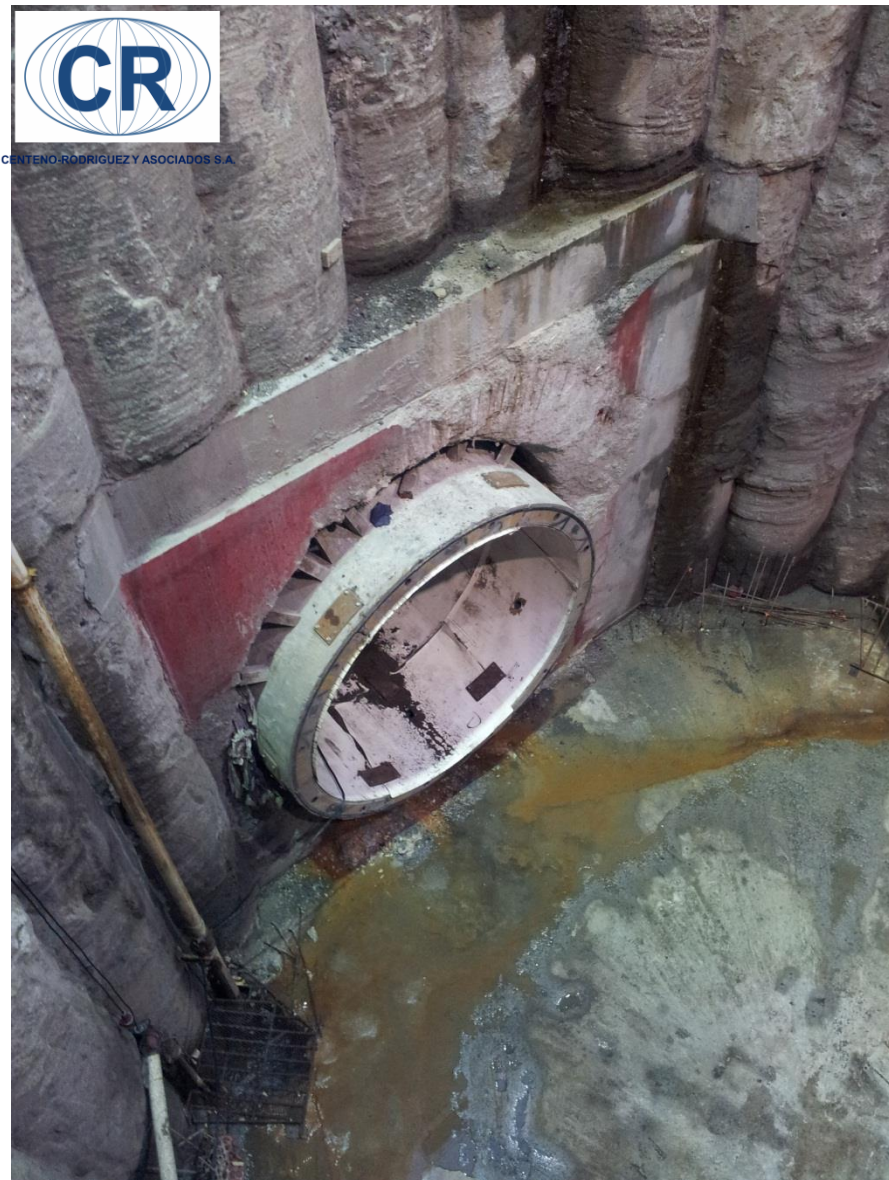
Foso de salida (Av. Balboa) Cinta Costera Ciudad Panamá Túnel interceptor: 8 Km con Ø3.4m
