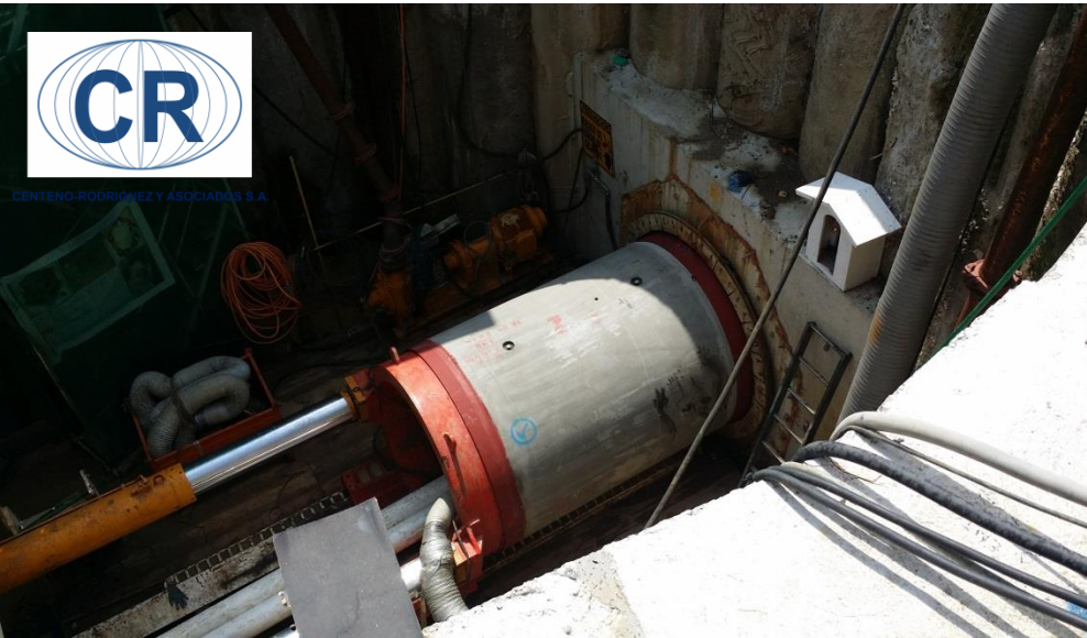
Empujando con 2 gatos hidráulicos el Tubo
