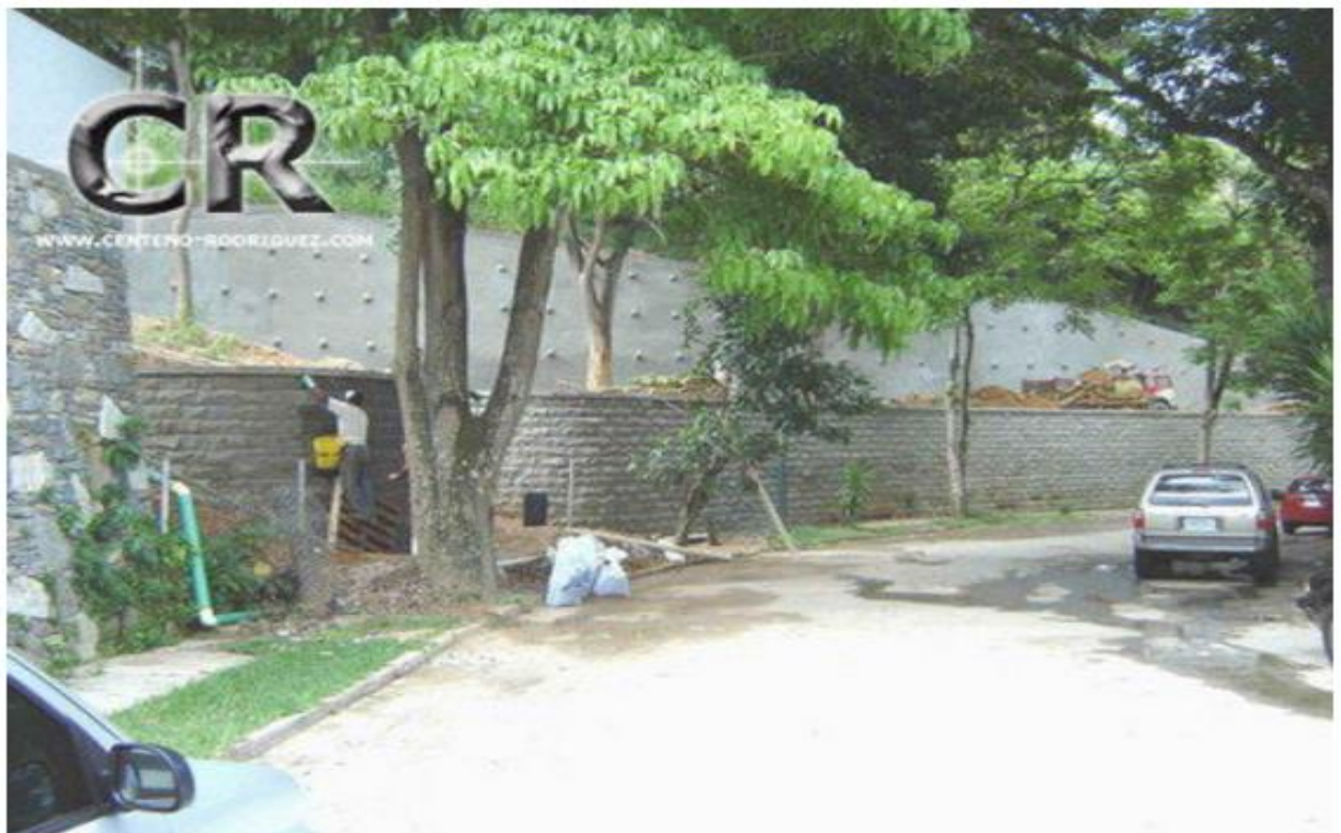
Vista Lateral del Muro Mesa y Pantalla Atirantada en Colegio Simón Bolívar III
