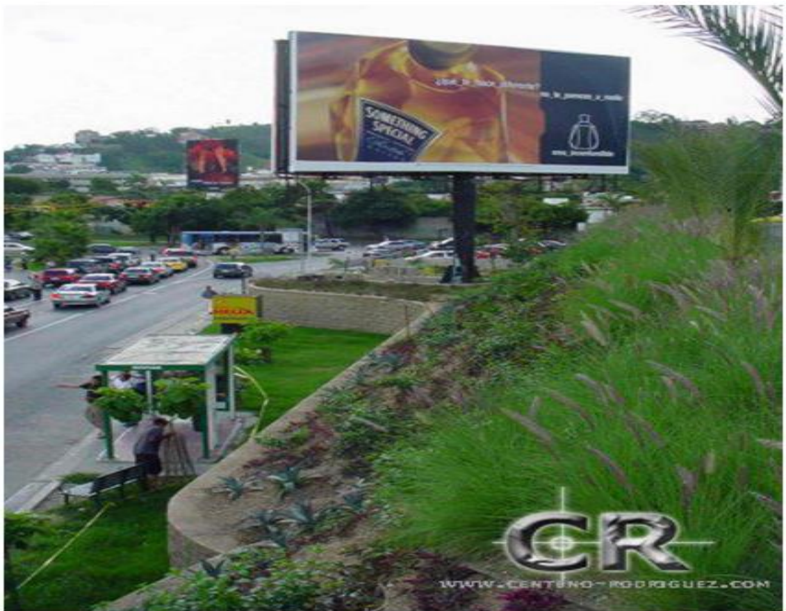
Proyecto Geotécnico de 11 muros de tierra reforzada con geomallas (TENSAR)
