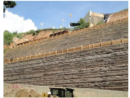
Resultado de la Hidrosiembra en el talud reforzado 2 meses después
