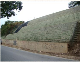
Hidrosiembra ejecutada sin Manto P550. Colocación del manto
