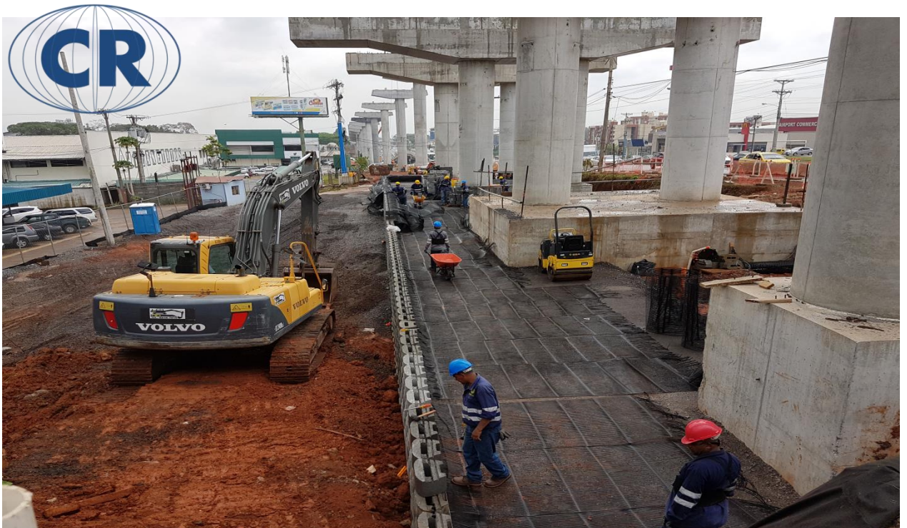
Aseguramiento Calidad en Compactaciones Muro Tierra Armada Línea 2 Metro de Panamá, Estación Don Bosco. Para: Envtech S.A.
