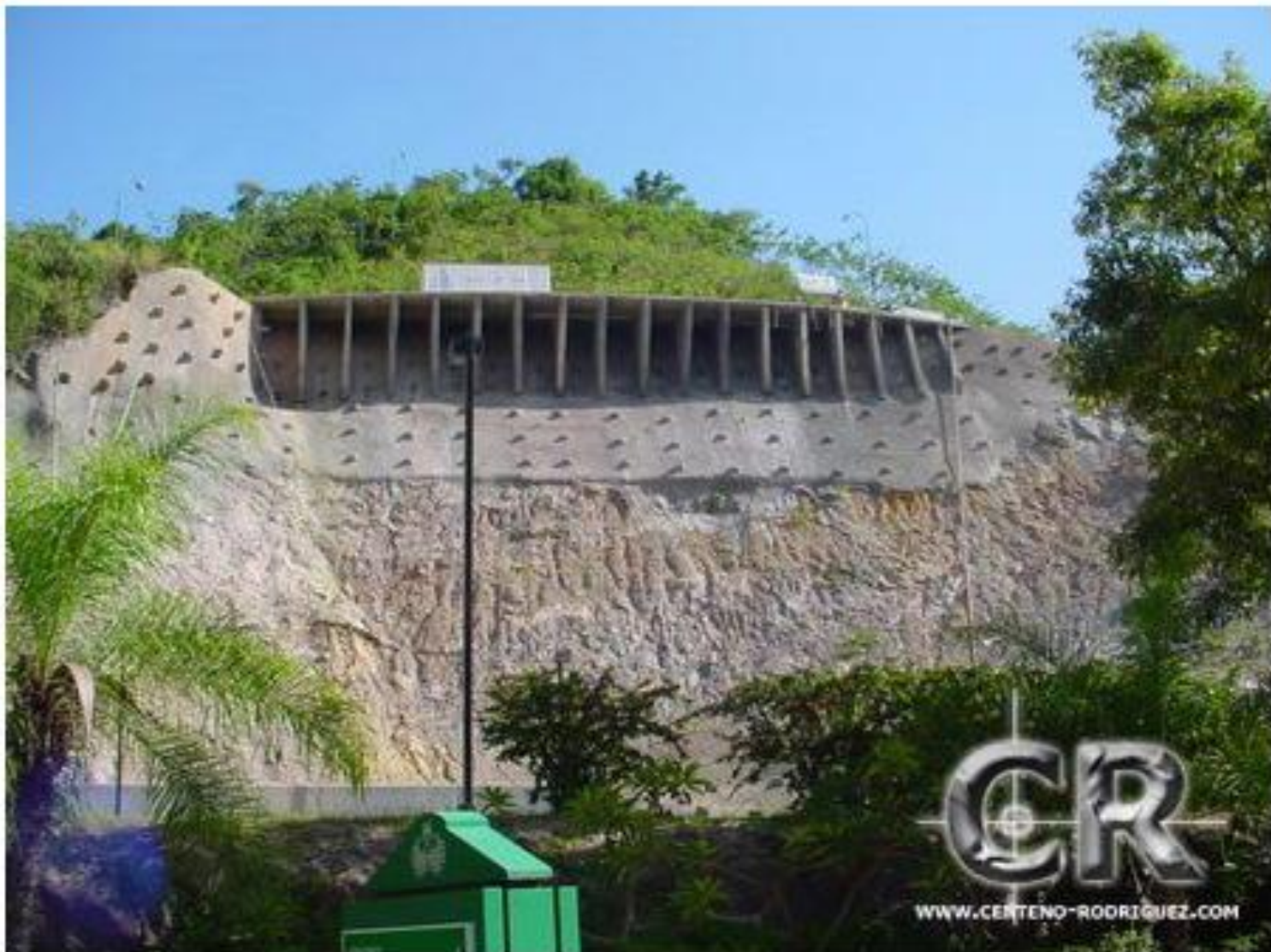
Diseño Geotécnico Pantalla Atirantada y Puente Eurobuilding-Lomita de Chuao Image 7 of 24
