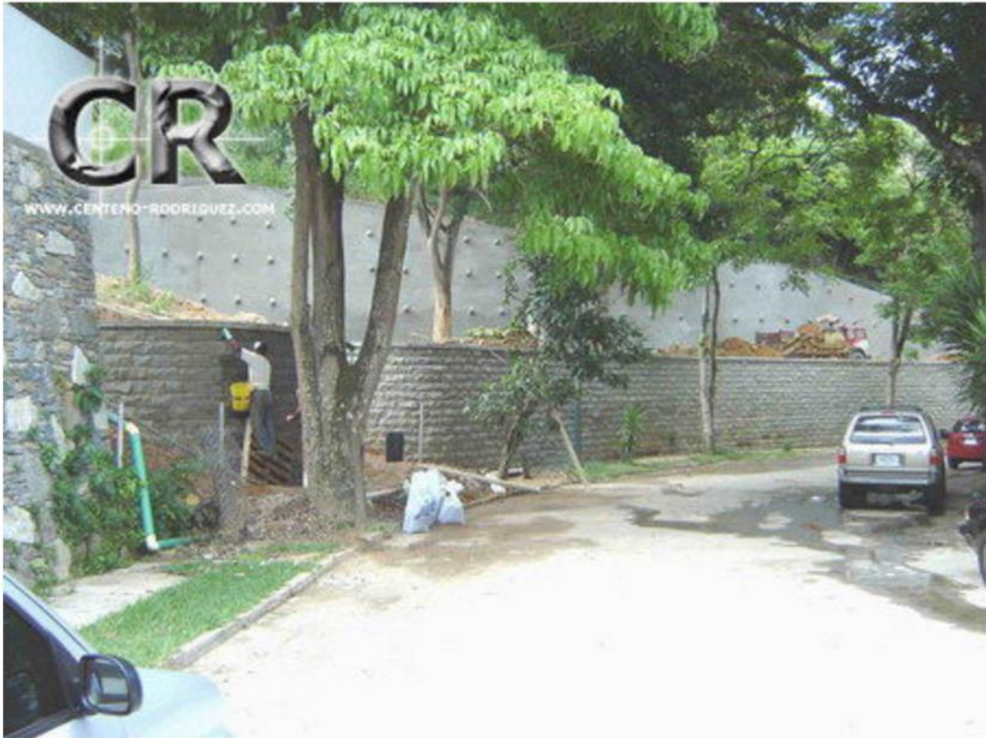
Vista Lateral del Muro Mesa y Pantalla Atirantada en Colegio Simón Bolívar III
