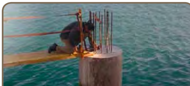
Fig. 12. Ejemplo de evaluación de la integridad del vaciado de concreto con el ensayo PET en un pilote para puentes o muelles en Costa afuera.
