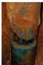
Fig. 10. Ejemplo de una interrupción muy importante en un pilote de 1.00 metros de diámetro.
