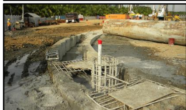
Sanearamiento de la Ciudad y de la Bahía de Panamá - Estaciones de Bombeo en Chanis y Pozo de Acceso TBM-EPB Ø 3,40m - Túnel 8 Km. 15 inclinómetros.
