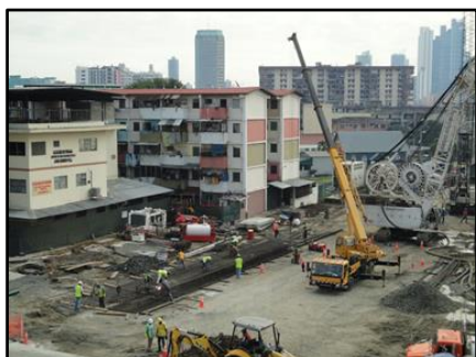
Línea 1 del Metro de Panamá. 8 Estaciones subterráneas - Túnel 8 Km - TBM-EPB Ø 9,80m 58 inclinómetros (barretas de muros colados estaciones y 5 pozos de ventilación y emergencia. 2 Secciones laterales de excavación al túnel).
