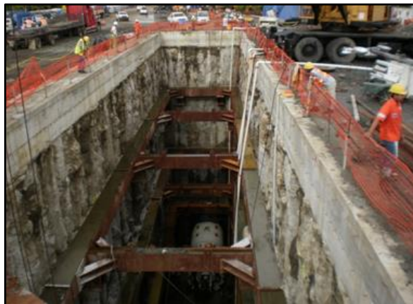
Sanearamiento de la Ciudad y de la Bahía de Panamá - Estaciones de Bombeo en Chanis y Pozo de Acceso TBM-EPB Ø 3,40m - Túnel 8 Km. 15 inclinómetros.
